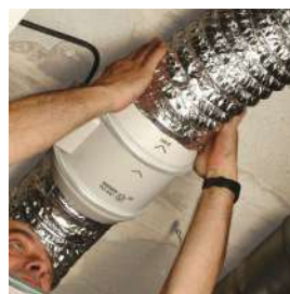
Acoplar los conductos.
