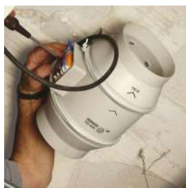
Realizar las conexiones.
