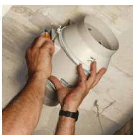
Colocar el cuerpo motor.
